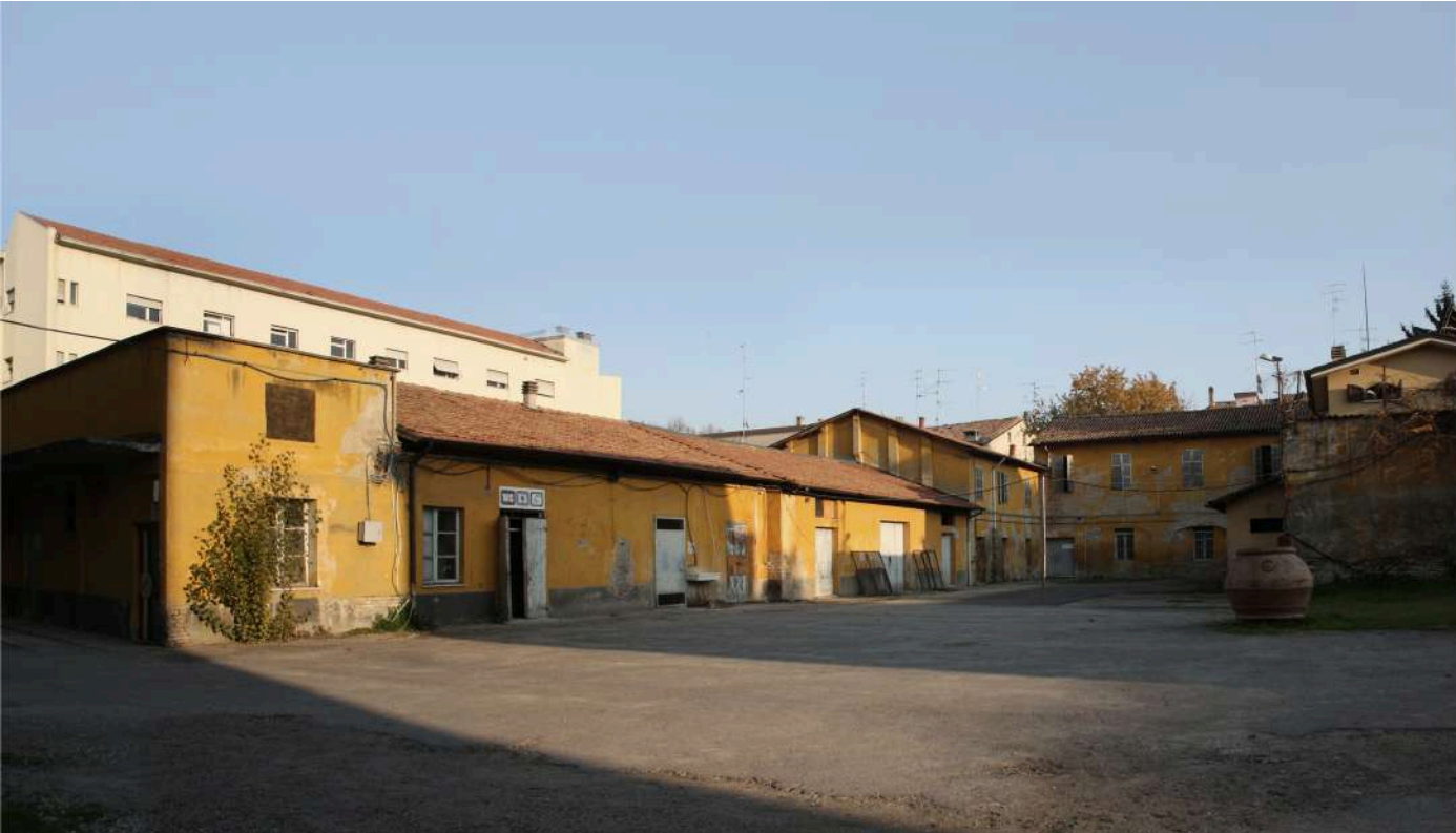
VISTA DEL LABORATORIO APERTO (FRONTE SUD) PRIMA E DOPO L'INTERVENTO
